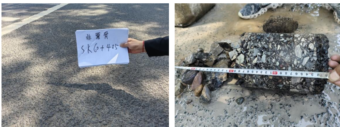
(6) K60+405 顺桩非机动车道位置露骨处
